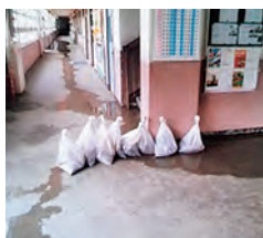
雨水の侵入を防ぐため廊下に土のうを並べている(東大阪市立小学校)
