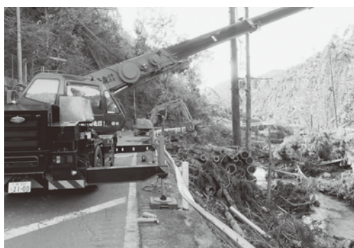
芥川上流の倒木撤去工事
