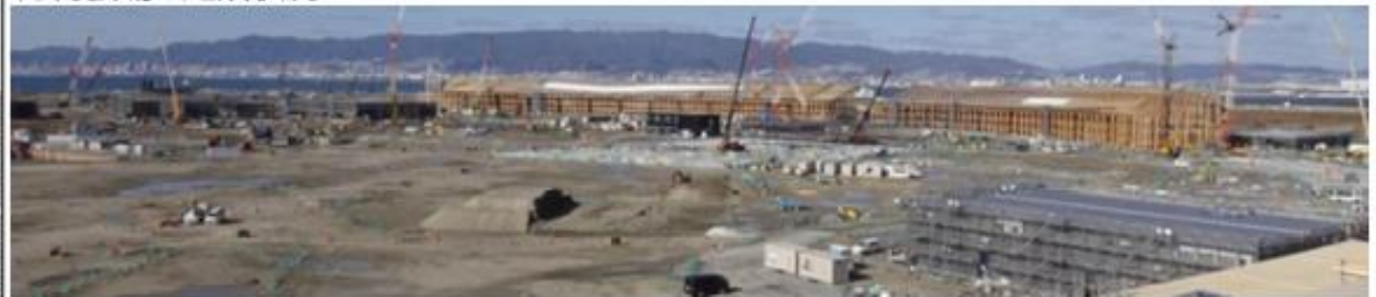
写真① 万博会場の建設状況
