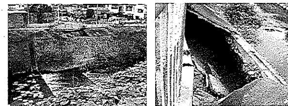
平野川（市町橋上流：老朽化護岸）
